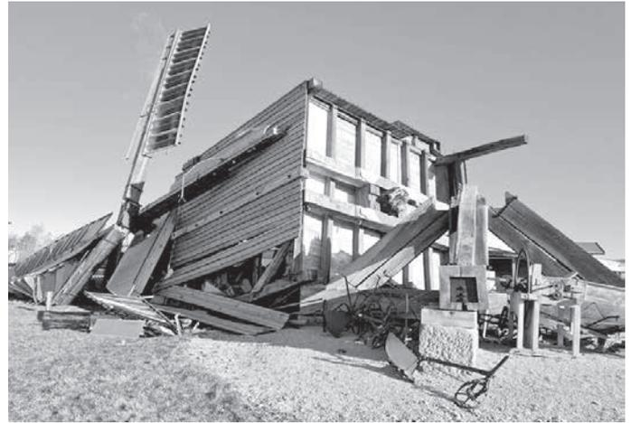
In der Nacht vom 18.02.2022 auf dem 19.02.2022 hat der Orkan Zeynep die im Jahr 1743 errichtete Bockwindmühle in Klettbach zerstört. Durch einen Bruch des Hausbalkens fiel Deutschlands höchstgelegene Bockwindmühle gegen 2 Uhr Nachts um und wurde sehr stark beschädigt.
